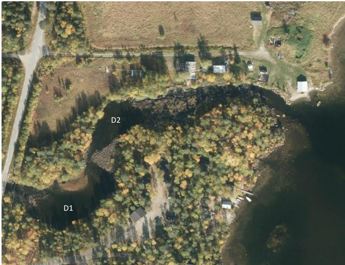
Figur 4.43. Flyfoto som viser segment D (D1 og D2).
